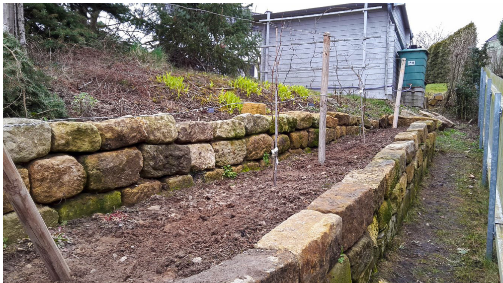
Abb. 18: Trockenmauer aus Sandsteinquadern.
